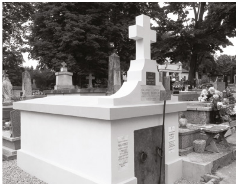
Grobowiec Machowiczów po renowacji
