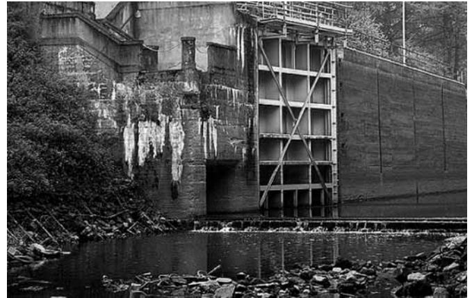
Fot. M. J. Jagła Wrota śluzy „Przewóz” od strony wody dolnej.
